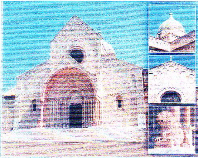
Facciata del Duomo
